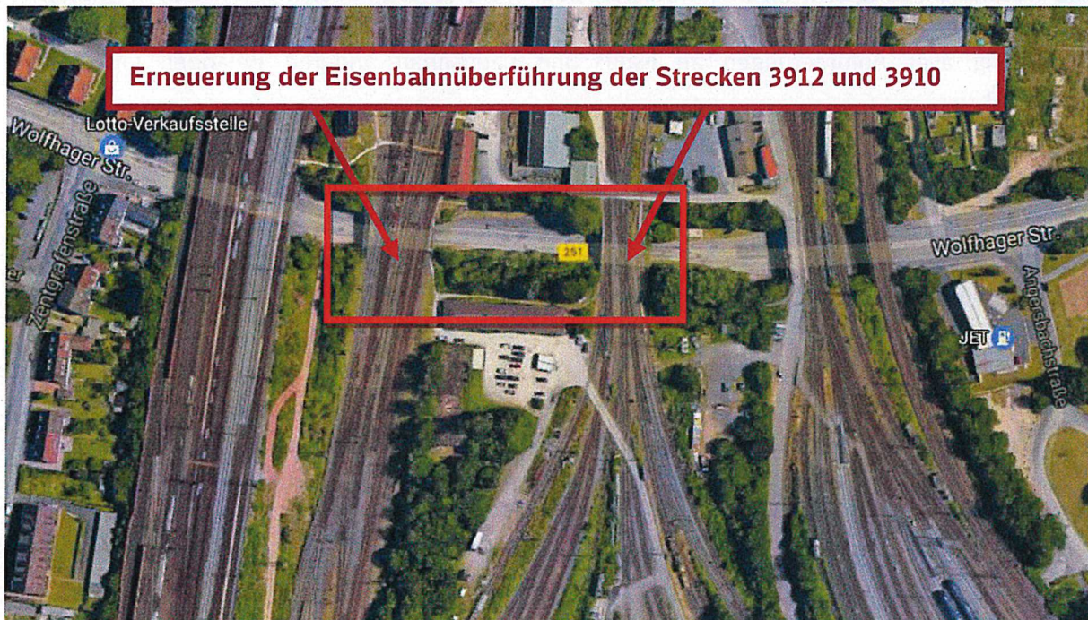
Abbildung 1: Lage des Eingriffsbereichs zur Erneuerung der Überführungen (Pfeile) und Anpassung der Straße.
