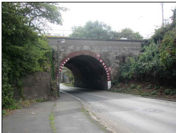
Abbildung 4 EÜ der Strecke 3910, Westseite [20]
