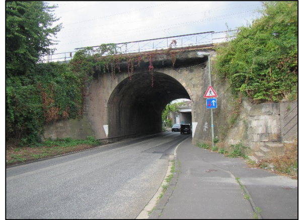
Abbildung 3: EÜ der Strecke 3912, Ostseite [20]
