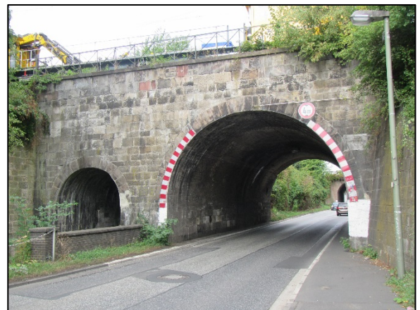
Abbildung 5: EÜ der Strecke 3910, Ostseite [20]
