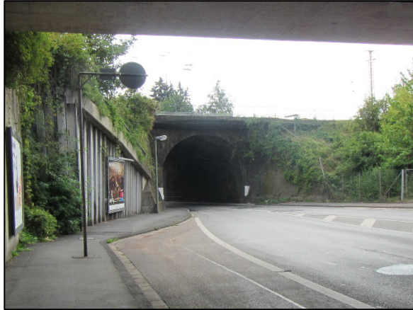
Abbildung 2 EÜ der Strecke 3912, Westseite [20]
