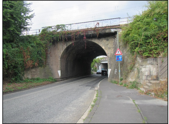
Abbildung 3: EÜ der Strecke 3912, Ostseite [22]
