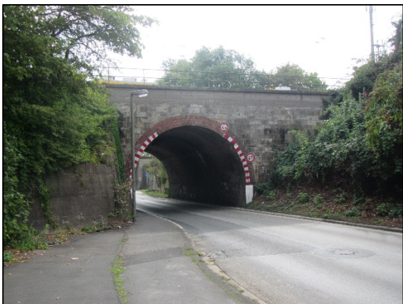
Abbildung 4 EÜ der Strecke 3910, Westseite [22]
