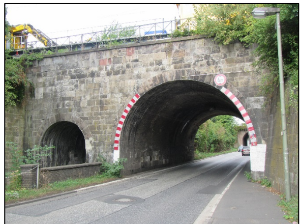
Abbildung 5: EÜ der Strecke 3910, Ostseite [22]
