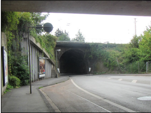
Abbildung 2 EÜ der Strecke 3912, Westseite [22]
