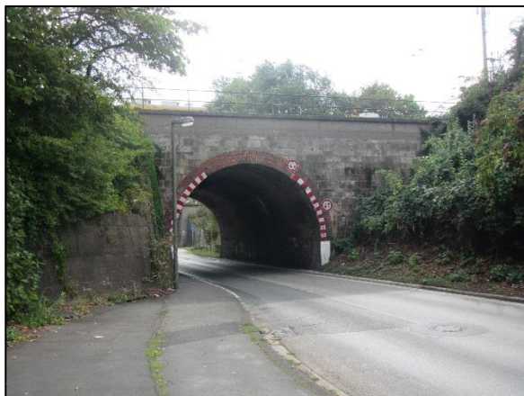
Abbildung 4 EÜ der Strecke 3910, Westseite [37]
