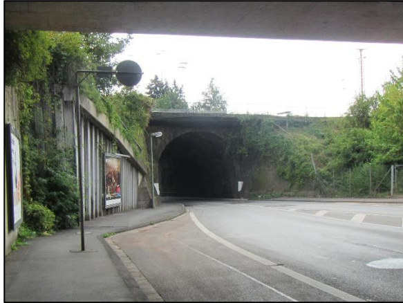
Abbildung 2 EÜ der Strecke 3912, Westseite [37]
