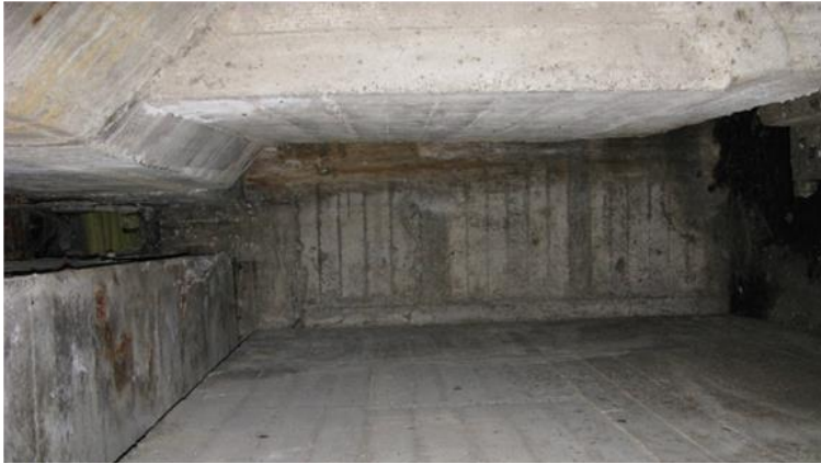
Abbildung 2: Brückenwiderlager bei der Sichtkontrolle im April 2011
