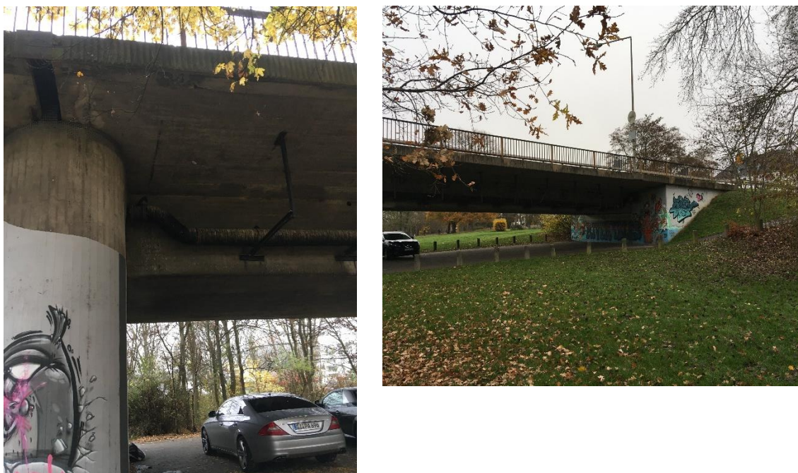
Abbildung 3-3: westlicher Brückenpfeiler (links) und östliches Widerlager (rechts) der Konrad-Adenauer-Brücke
