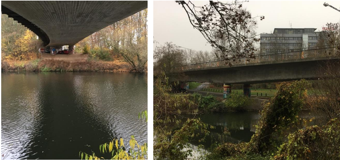
Abbildung 3-6: links: Westufer der Lahn mit Pfeilern im Ist-Zustand; rechts: Pfeiler (Ist-Zustand) am Ostufer der Lahn
