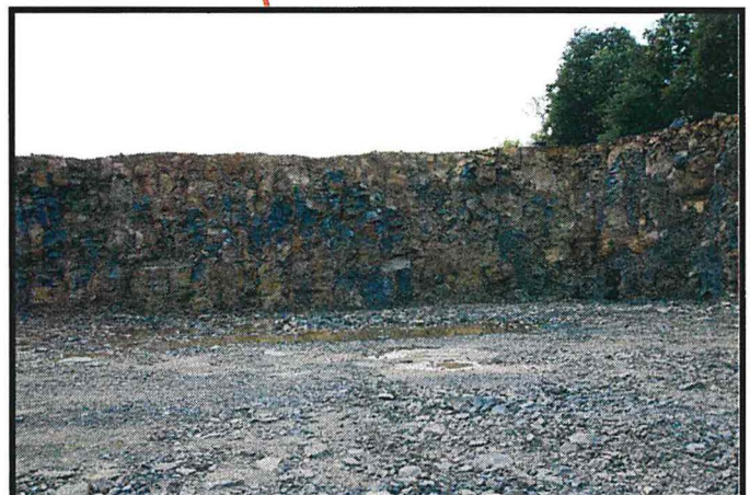
keine Wasserzutritte erkennbar (Abbausohle ca. 10 m u. GOK)
