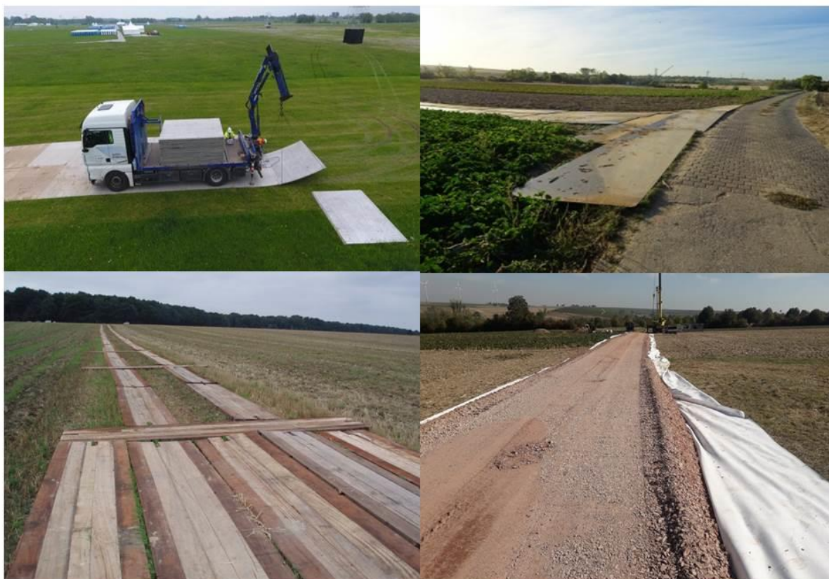
Abbildung 9: temporärer Wegebau Aluminium Fahrplatten (oben links), Stahlplatten (oben rechts), Fahrbohlen (unten links) und Schotter auf Geotextil (unten rechts)
