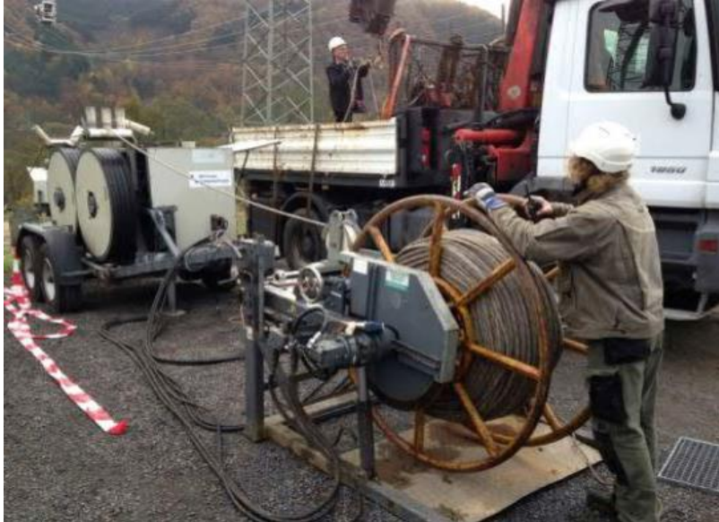
Abbildung 12: Seilbremse und -winde
