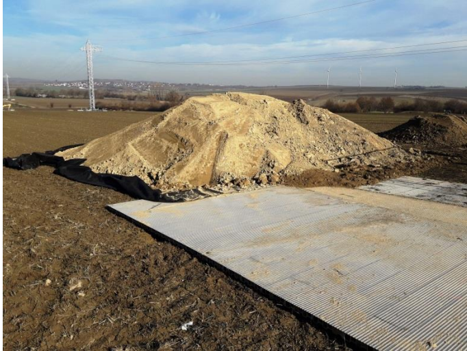
Abbildung 10: Beispiel für eine Unterbodenmiete auf Geotextil
