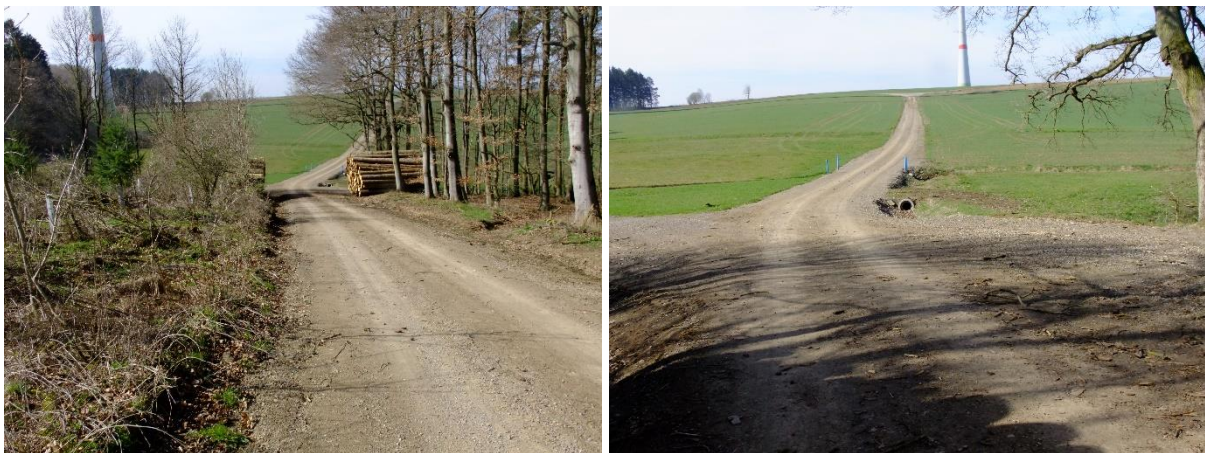
Abbildung 8: Ausgebaute Zuwegung zwischen WEA 5 und WEA 1 mit Blick auf den (verrohrten) Erlenbach
