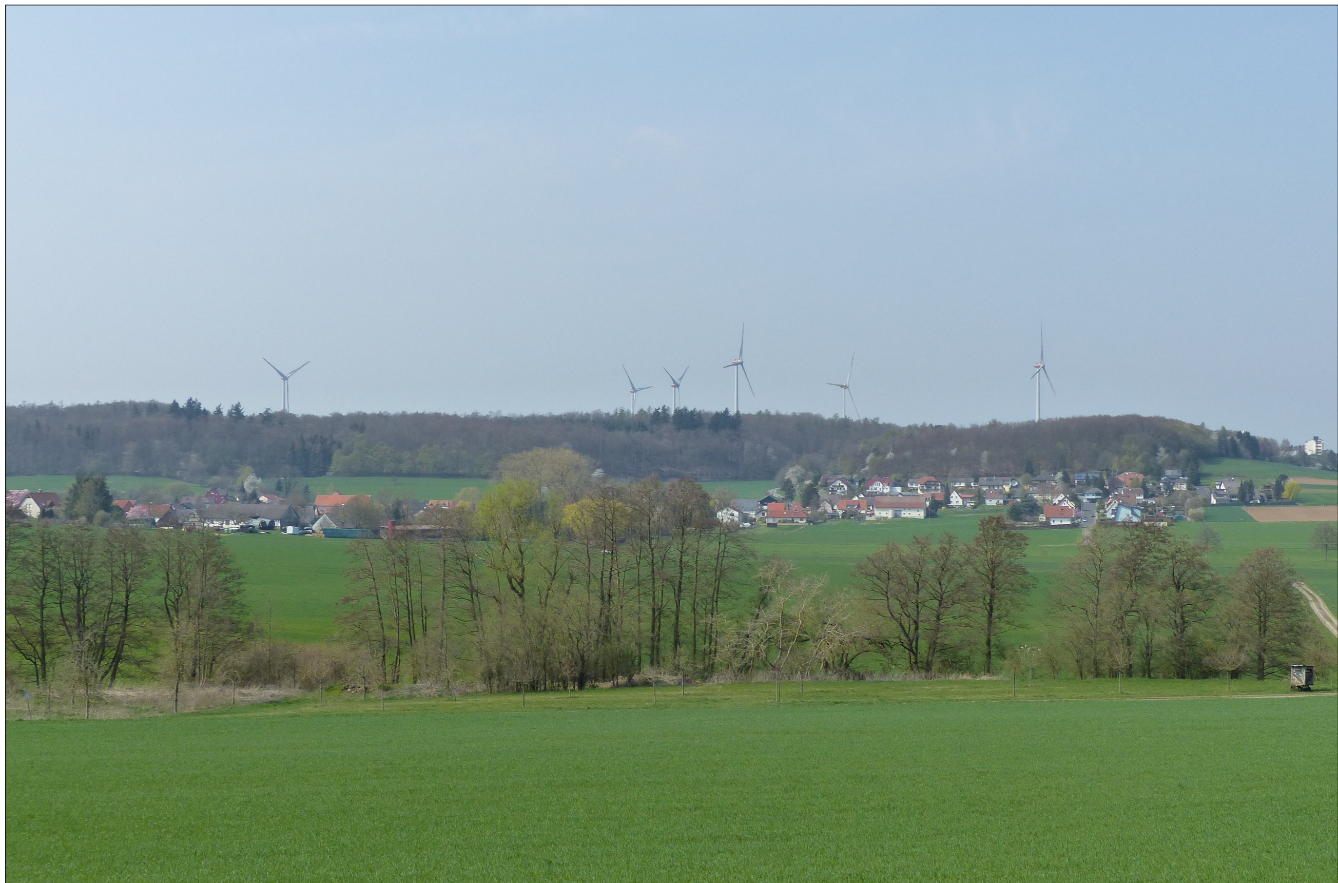
Empfohlener Betrachtungsabstand: 49 cm - Aufnahme: 09.04.2019, 13:43 Uhr, UTM (north) ETRS89 Zone 32 Ost: 518.404 Nord: 5.619.011, Brennweite: 52 mm, Richtung: 295°
