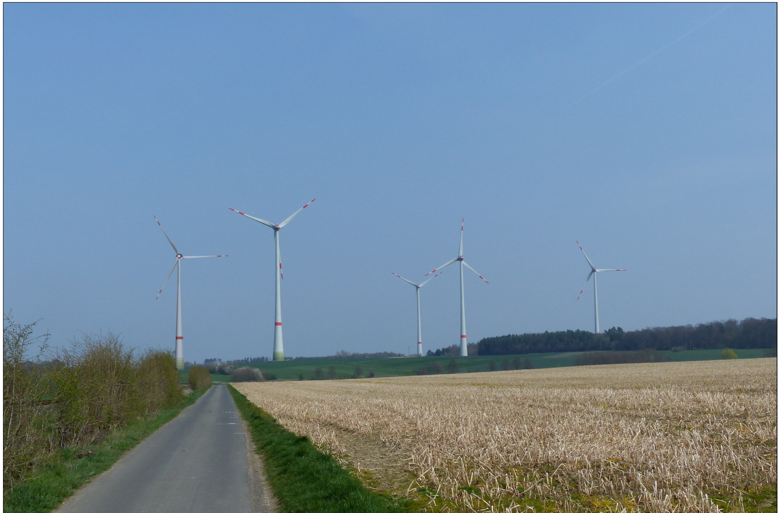
Empfohlener Betrachtungsabstand: 48 cm - Aufnahme: 09.04.2019, 13:13 Uhr, UTM (north) ETRS89 Zone 32 Ost: 514.367 Nord: 5.619.728, Brennweite: 51 mm, Richtung: 67°
