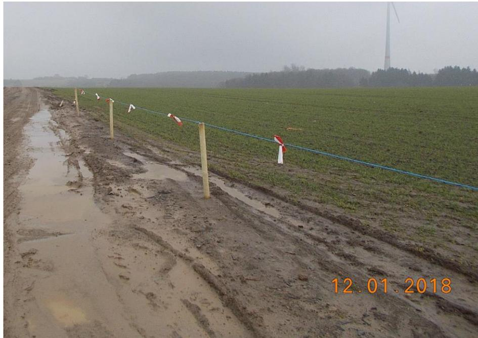
**Abb. 12:** Beispiel einer Baufeldbegrenzung mittels Pfosten, Spanschnur und Flatterband
