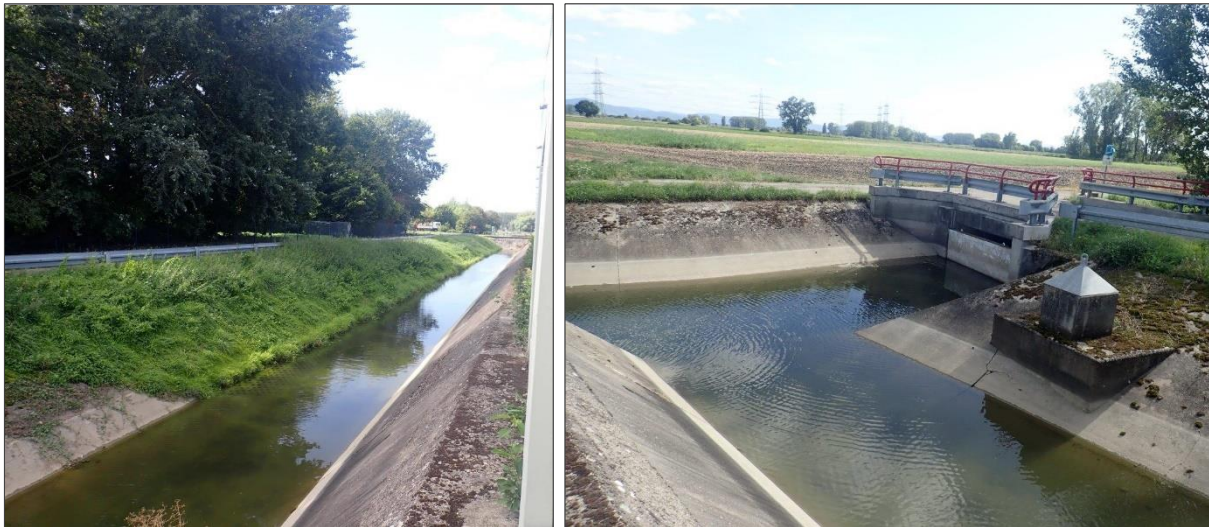
Abbildung 1: Mörschgraben westlich des Kraftwerksgeländes (links) und am Schieberbauwerk (rechts)
