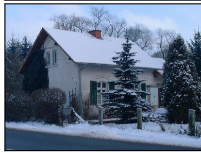
Wohnhaus Bahnwärterhaus Korbacher Str. 2 re > S / li > W
