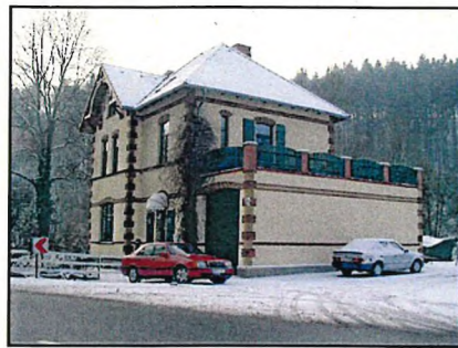
Wohnhaus Alter Bahnhof Haus Nr. 3 re > N / li > O
