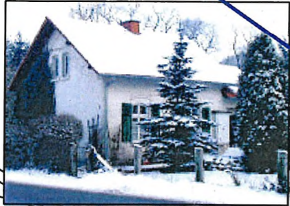
Wohnhaus Bahnwärterhaus Korbacher Str. 2 re > S / li > W
