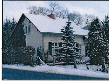
Wohnhaus Bahnwärterhaus Korbacher Str. 2 re > S / li > W
