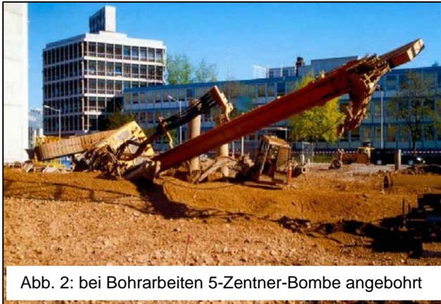
Abb. 2: bei Bohrarbeiten 5-Zentner-Bombe angebohrt
