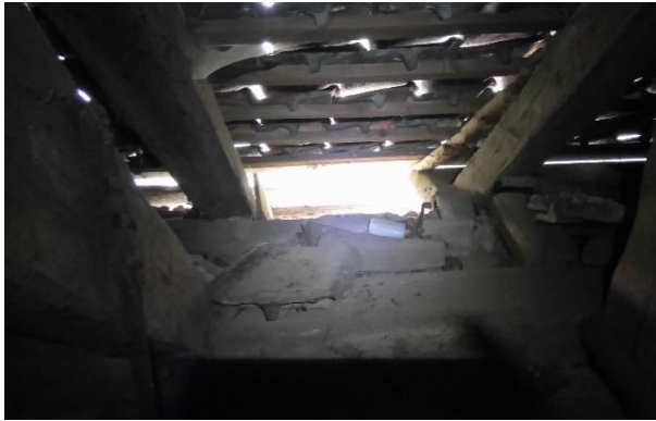
Abb. 4-1: Dach Schwalbenthal Gebäude
