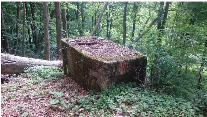
Abb. 4-7: Hilfsstollen / Fundament ohne Öffnung
