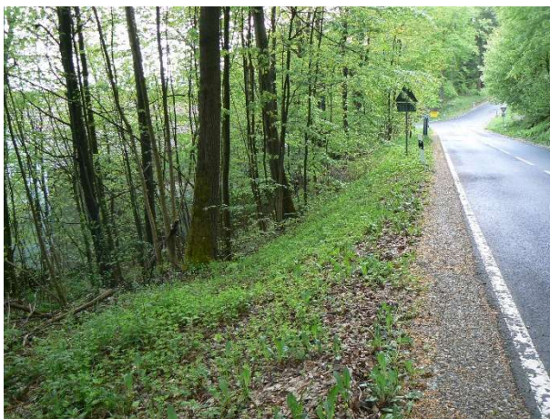
Abbildung 3: L3242, Blick zum Knoten und talseitige Böschung
