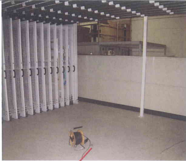
Messpunkt 2: MWK (6. OG Geschossdeckenmitte)
