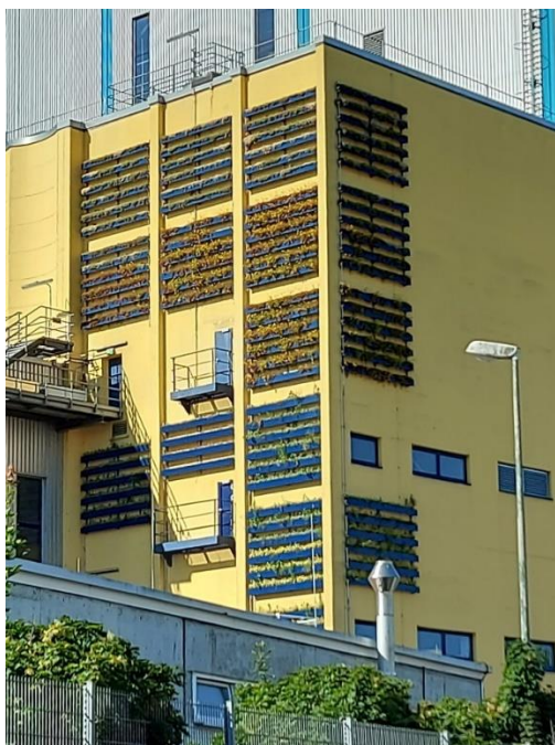
Abbildung 10-4: Begrünung der Nordfassade (Status 6/2023) und Detaildarstellung Bepflanzungssystem (MHKW, 2024)
