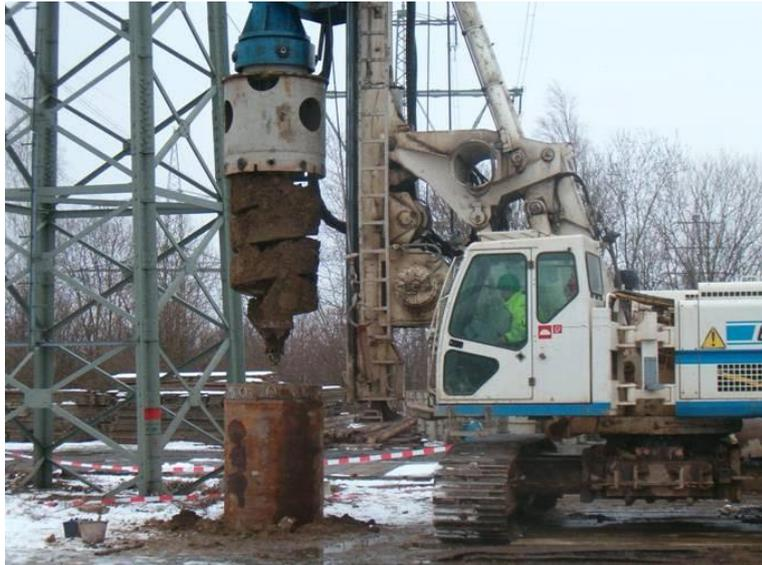
Abbildung 1 Bohrung für eine Bohrpfahl
