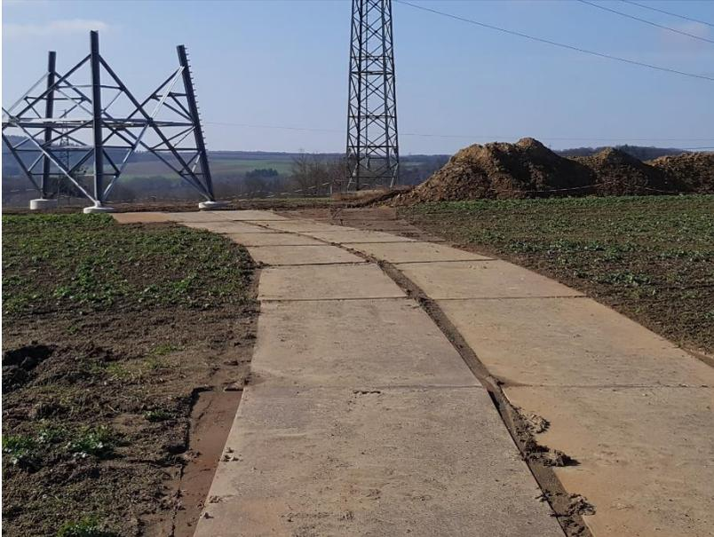
Abbildung 2 Temporäre Zufahrt über Stahlplatten
