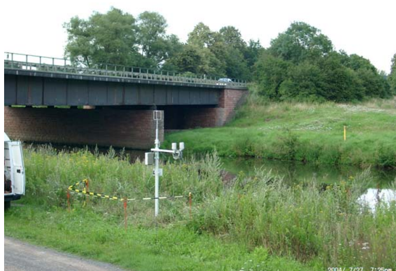
Abbildung 4: Bilder des temporäres Messpunktes 1
