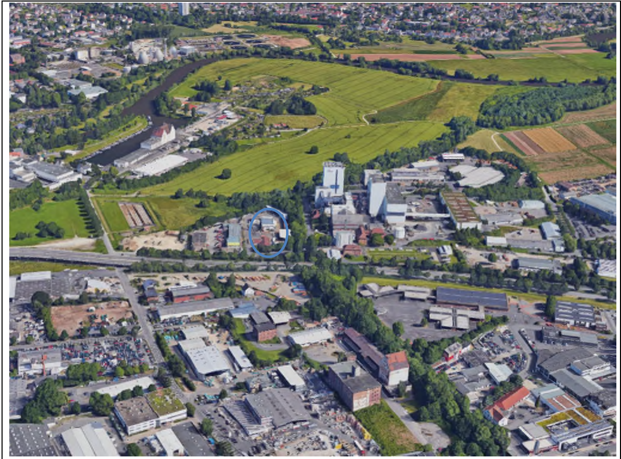
Abbildung 16: Schrägluftbild von Standort und Umfeld, Ansicht von Süd (Quelle: google maps)
