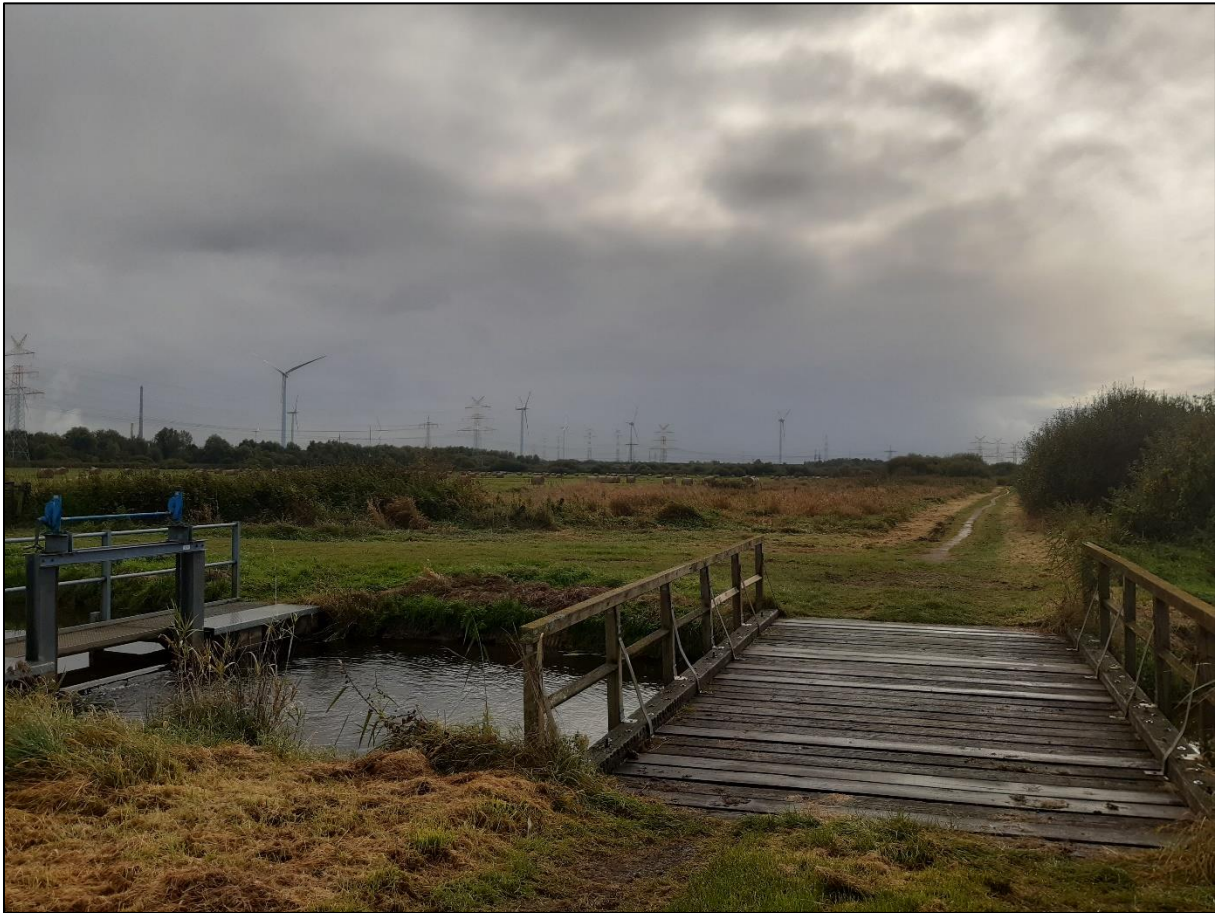
Abb. 20: Blick vom Ökopfad auf Höhe Querweg: etwa über dem Brückengeländer in der Bildmitte ist der nicht von höherwüchsigen Gehölzen bestandene nördliche Randdamm der Deponie 2 (Schlammdeponie) zu erkennen
