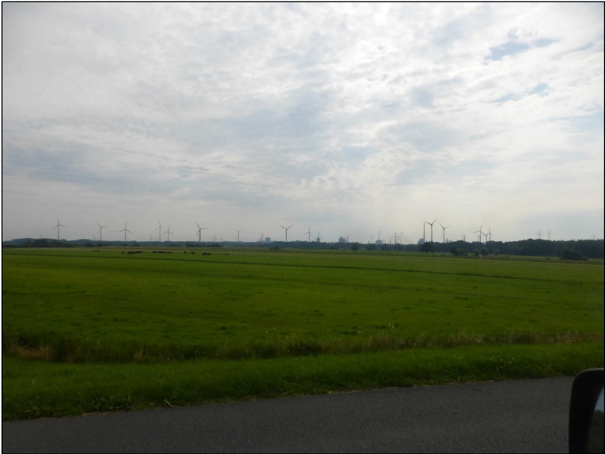
Abb. 19: Blick von der Niederbürener Landstraße (etwa Höhe Deponie 2) auf das Werksge- lände
