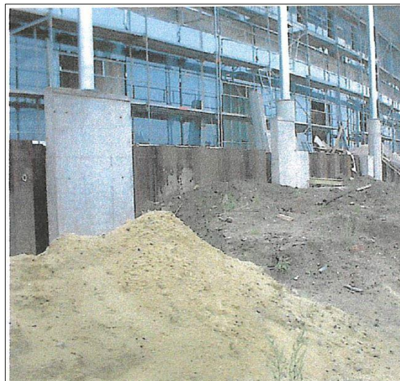
Abbildung 3-11: Teilabschnitt I – Baustellenfoto der öffentlichen HWS-Wand
