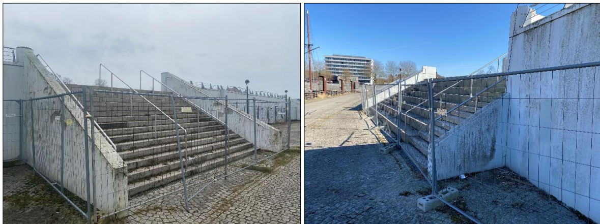
Abbildung 3-29: Treppenkonstruktionen – Treppe 1 (links); Treppe 2 (rechts)
