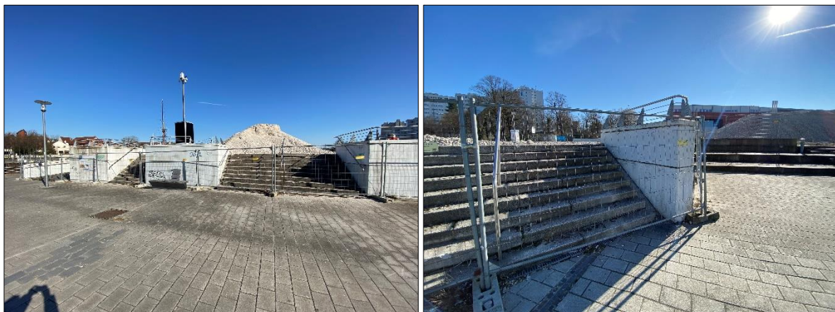
Abbildung 3-30: Treppenkonstruktionen – Treppe 3 und 4 (links); Treppe 5 (rechts)
