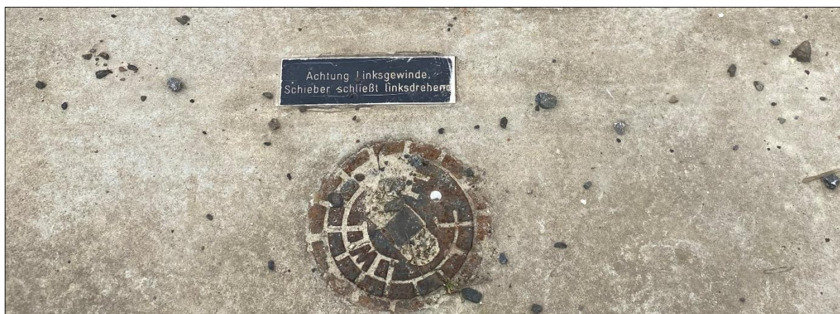
Abbildung 4-29: Beschreibung zur Betätigung eines Schiebers
