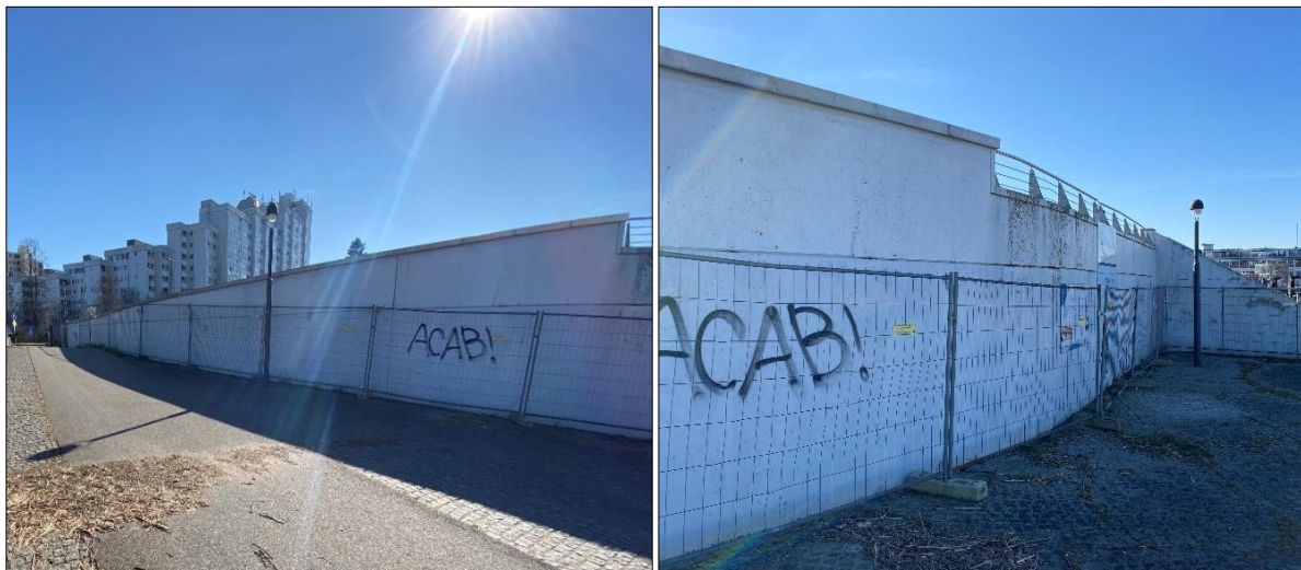
Abbildung 3-7: Teilabschnitt I – Wasserseitige Ansichten der öffentlichen HWS-Wand entlang der Rampe (links) und dem Abschnitt nach der Rampe (rechts)
