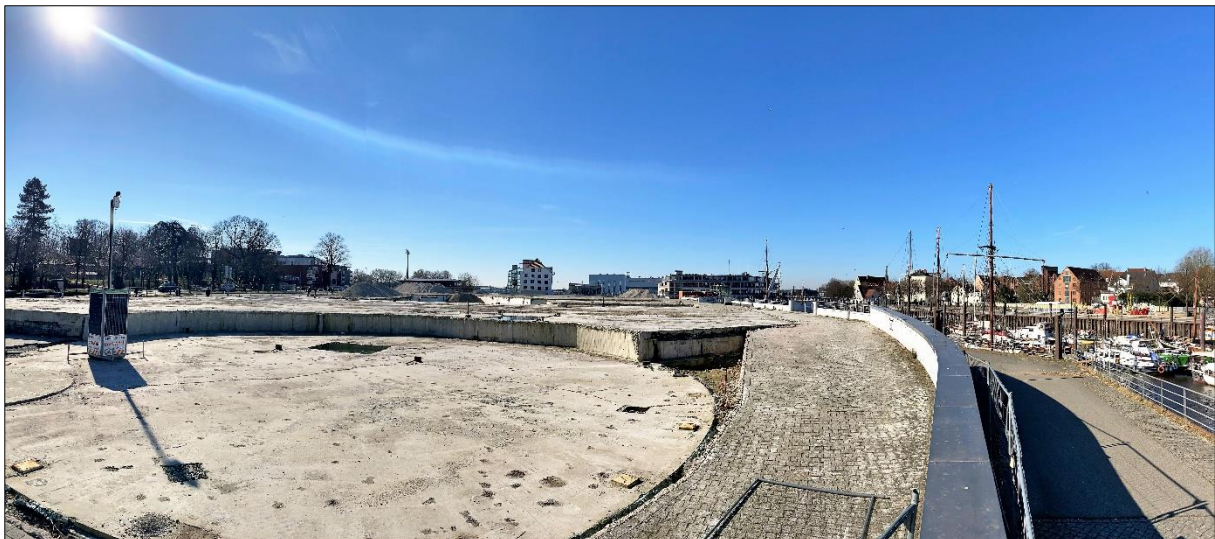
Abbildung 2-3: Örtliche Verhältnisse im Abschnitt C nach Abriss des Haven Hööv't Gebäudes (Blick vom Beginn des Planungsgebietes auf das freie Baufeld Speicherquartier)
