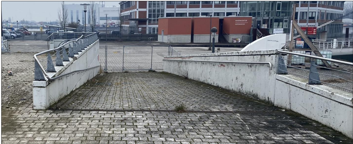
Abbildung 3-24: Teilabschnitte VII – Rampe
