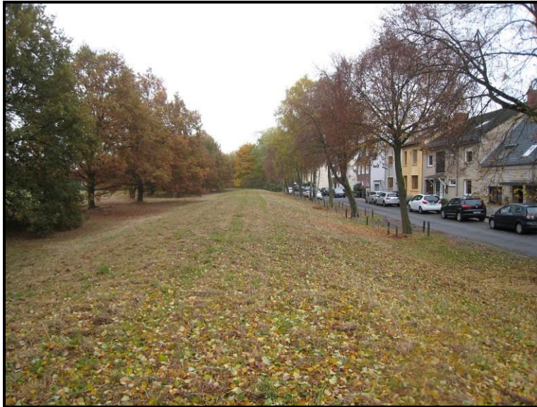
Abb. 1: Deich mit beidseitigen Baumreihen, Blickrichtung Osten
