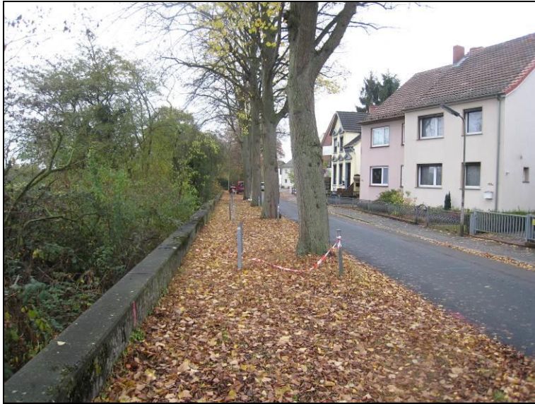
Abb. 5: HWS-Spundwand am Westerdeich, Blickrichtung Osten
