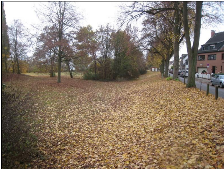
Abb. 9: Deich zwischen Treppenbauwerk und Gasregelstation, Blickrichtung Süden
