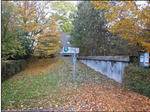
Abb. 6: Überfahrt Kompassweg mit verschwenkender Spundwand bei Station 0+432
