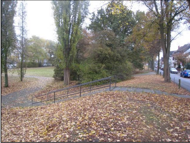
Abb. 11: Treppenbauwerk und Querung Grünanlage Westerdeich
