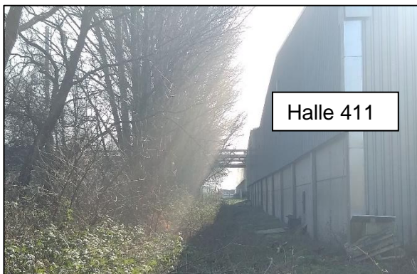
Abbildung 3: Bestehende Verhältnisse im Bereich der Halle 411 (Nord)
