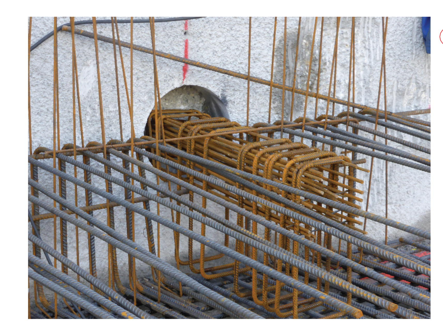
Detail D1 Kopplung Bodenplatte an Pfahlwand (Auftrieb)
