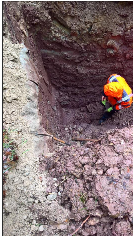
Foto 4 – Schurf 2 (Bereich KRB11); anstehender Boden (Ton/Tonstein); Rohrscheitel bei 3,0 m u. GOK
