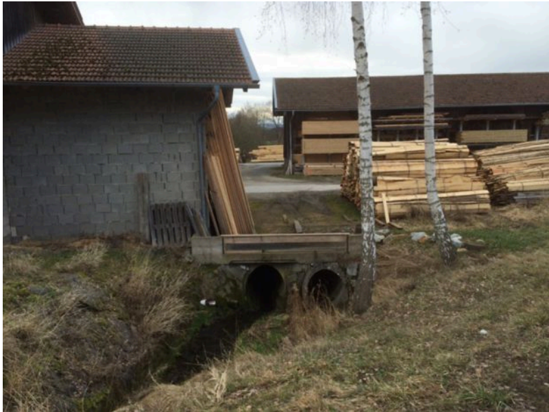
Holzlagerung im Überschwemmungsbereich der Dammermühle
