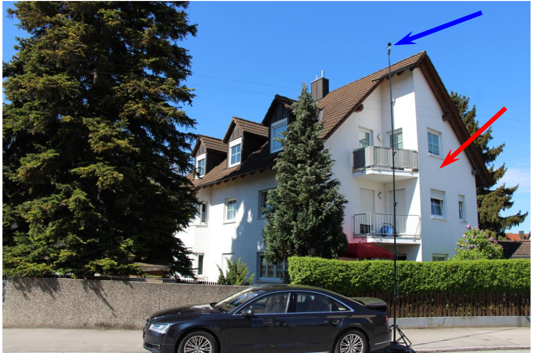
Foto 11: Blick in Richtung Westen auf die Ostfassade (roter Pfeil) des Wohngebäudes IO 2 „Georg-Reismüller-Straße 19“ in einem „Allgemeinen Wohngebiet“. Der Standort des Messmikrofons in h = 7,5 m Höhe über Gelände ist blau markiert.
