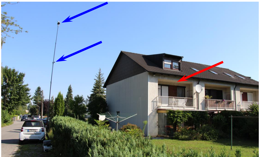
Foto 10: Blick in Richtung Nordosten auf die Südfassade (roter Pfeil) des Wohngebäudes IO 1a „Peter-Müller-Straße 4“ , das sich im B-Plan-Gebiet Nr. 978 „Peter-Müller-Straße“ in einem „Allgemeinen Wohngebiet“ befindet. Die Messungen erfolgten in ca. 9,5 m Abstand westlich vom Wohngebäude (unterer blauer Pfeil) in 5,5 m Höhe über Gelände. Der obere blaue Pfeil kennzeichnet den Standort der Wettermessstation.
