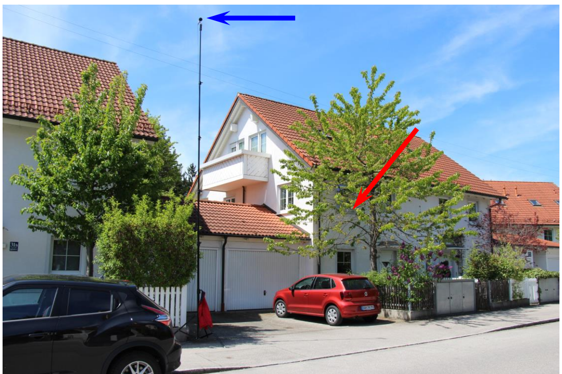
Foto 12: Blick in Richtung Nordwesten auf die Ostfassade (Pfeil) des Wohngebäudes IO 2a „Georg-Reismüller-Straße 31c“ in einem „Allgemeinen Wohngebiet“. Der Standort des Messmikrofons in h = 7,5 m Höhe über Gelände ist blau markiert.
