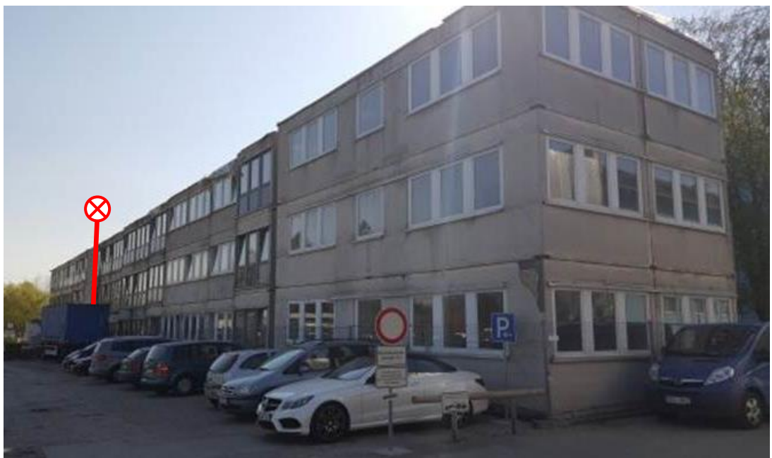
Foto 24: Blick in östliche Richtung auf die temporären Wohn-Container an der „Reinhard-von-Frank-Straße“. Die Messungen für den IO 7 „Tubefußstraße 19B“ erfolgten an einem Ersatzmessort in 25 m Abstand vom Gebäude in nordwestlicher Richtung, sowie in h = 11,5 m Höhe über Gelände (siehe Markierung).
