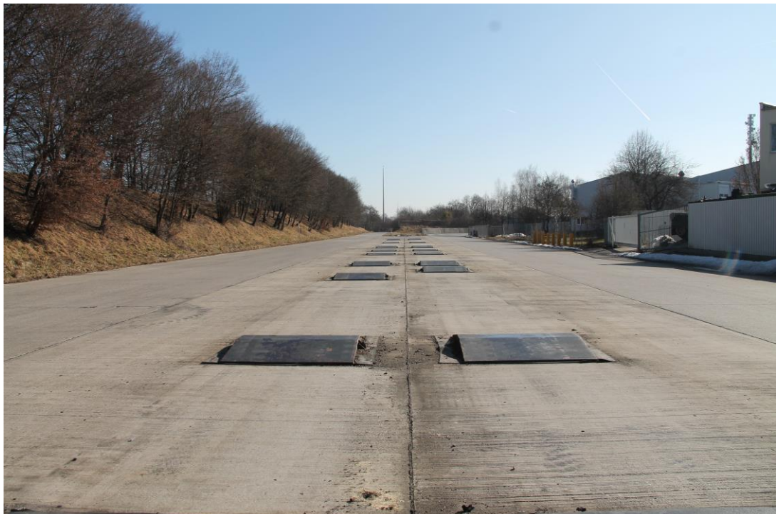
Foto 2: Blick von der Mitte der APG-Bahn in Richtung Südosten zur südöstlichen Wendeschleife der Panzerteststrecke.
