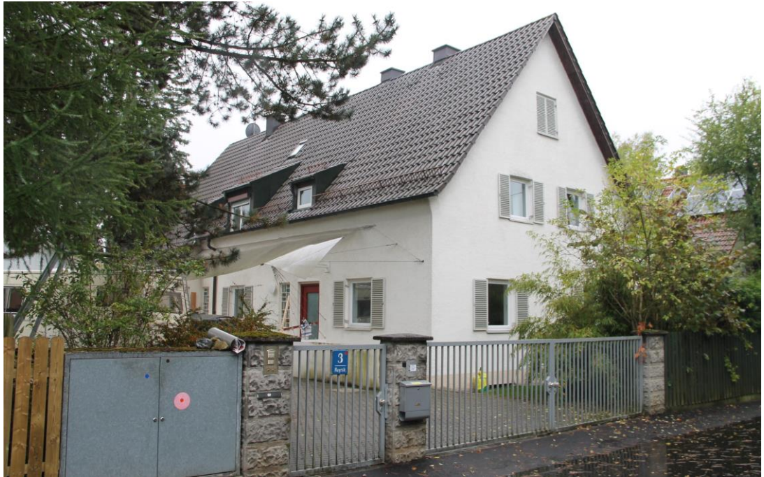
Foto 9: Blick in Richtung Südwesten auf die Ostfassade (links) und die Nordfassade (rechts) des Wohngebäudes IO 1 „Mayrstraße 3“ , das sich in einem „Allgemeinen Wohngebiet“ befindet. Die Messungen erfolgten in ca. 20 m Abstand in südöstlicher Richtung vom Wohngebäude in h = 8 m Höhe über Gelände auf dem vorhandenen Radweg.
