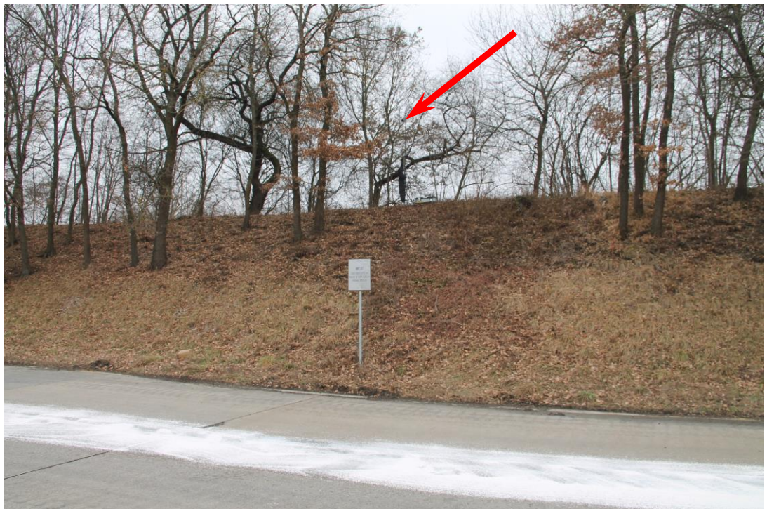
Foto 4: Blick von der nordwestlichen Wendeschleife in Richtung Norden auf den gewählten Emissionsmessort EMO 1 in h = 3 m Höhe über dem h = 4 m hohen Erdwall nordöstlich der Panzerteststrecke und in 8,5 m senkrechtem Abstand vom nordöstlichen Rand der betonierten Fahrbahn, siehe roter Pfeil.
