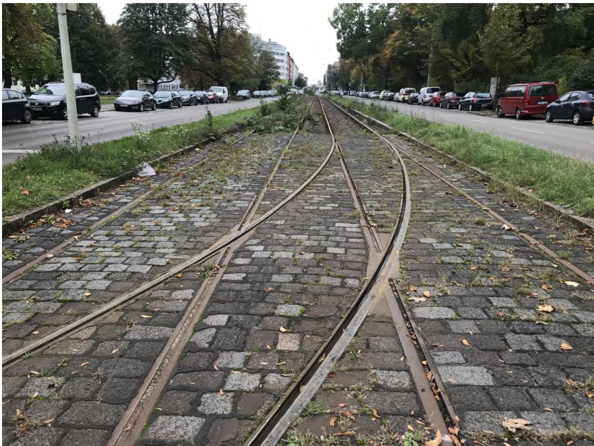
Abbildung 18: Gleise entlang Bayreuther Straße im Bereich Stadtpark
