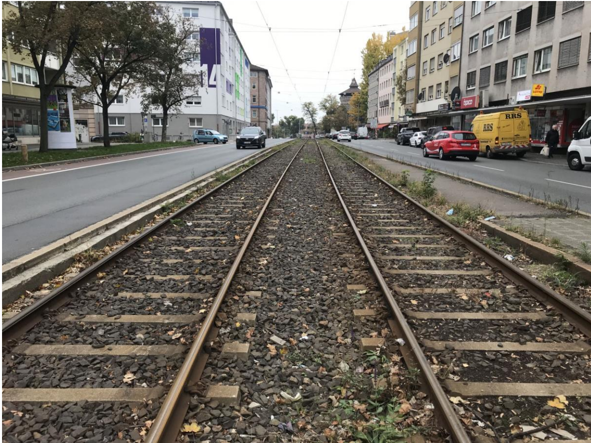
Abbildung 5: Schottergleis zwischen Rathenauplatz und Rennweg
