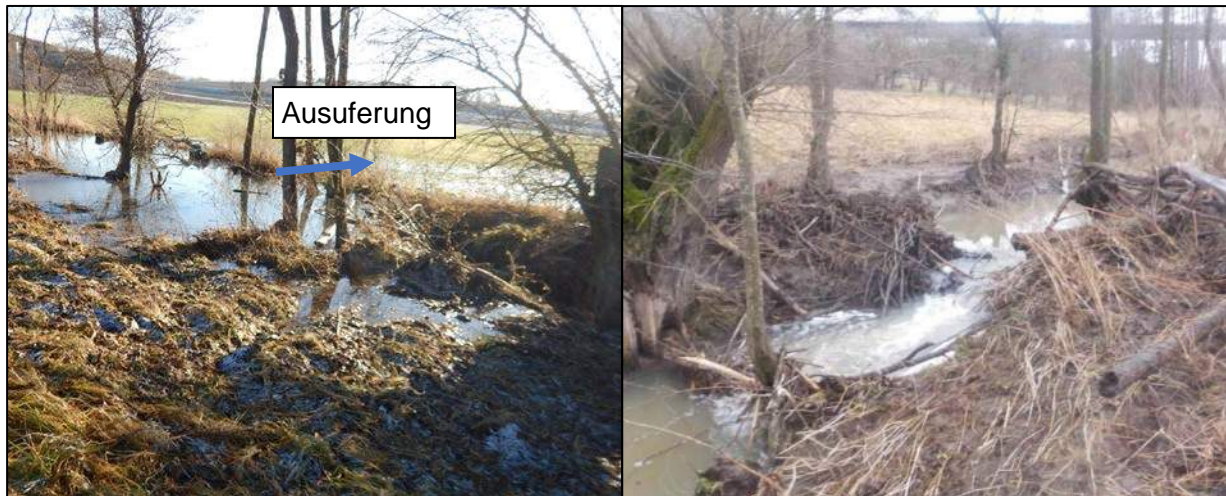
Abbildung 3-6: Zustand Biberdamm Profil 0001904, ca. 250 m unterstrom der Talbrücke; links: intakter Damm mit Aufstau Wasserspiegel und Ausuferung in linkes Vorland (Dezember 2021); rechts: geräumter Damm ohne Aufstau und Ausuferung (Januar 2022)
