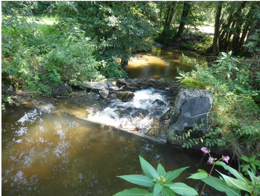
Abbildung 4: Bestand Wehranlage (Foto: IB Pfeffer)
