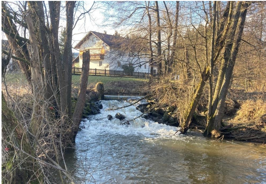
Wehr der ehemaligen Wasserkraftanlage (Foto: IB Pfeffer)
