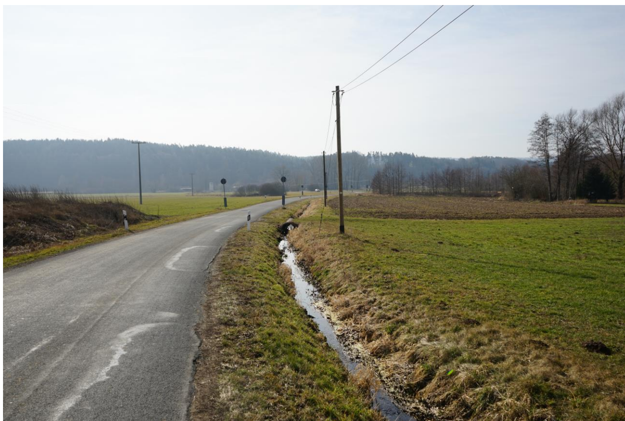
Abbildung 8: Rohrbach im Ausbaubereich – Blickrichtung Main/Ausbaubeginn
