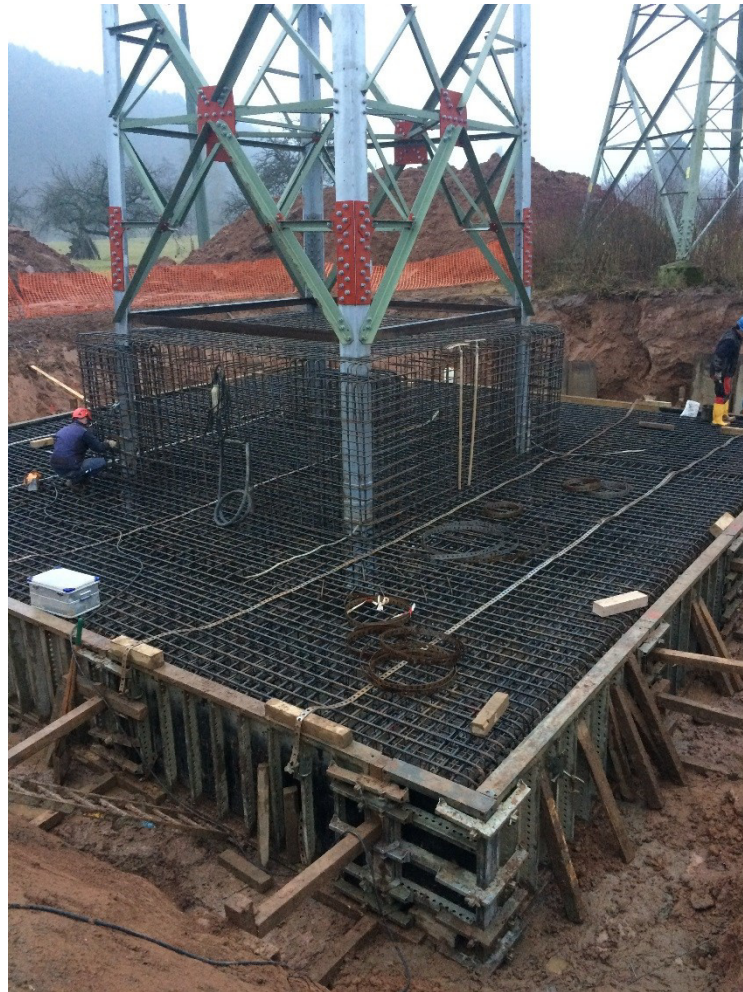
Abbildung 14: Beispiel für Fundamentsanierungsarbeiten, Schalung und Bewehrungsstahl
