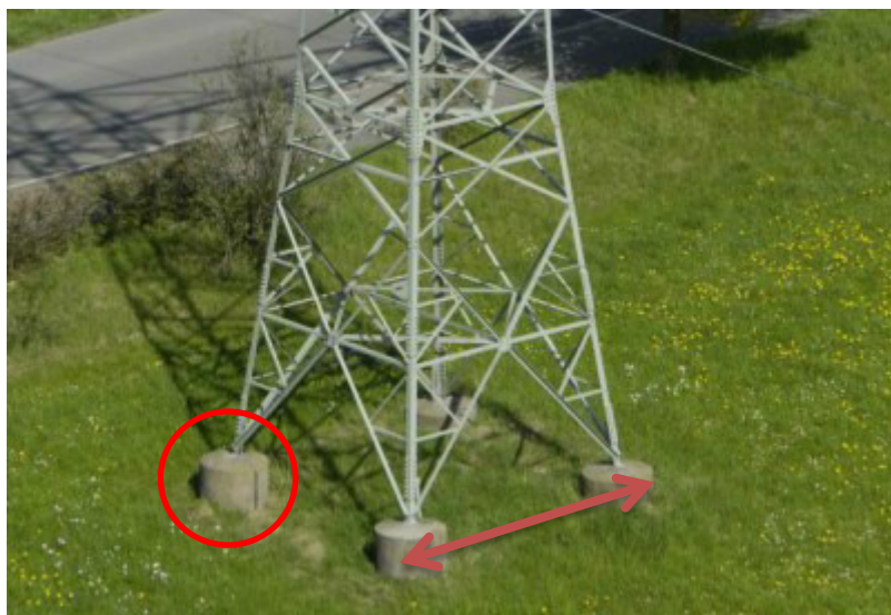
Abbildung 1: Sichtbare Betonfundamentköpfe und Bodenaustrittsmaß
