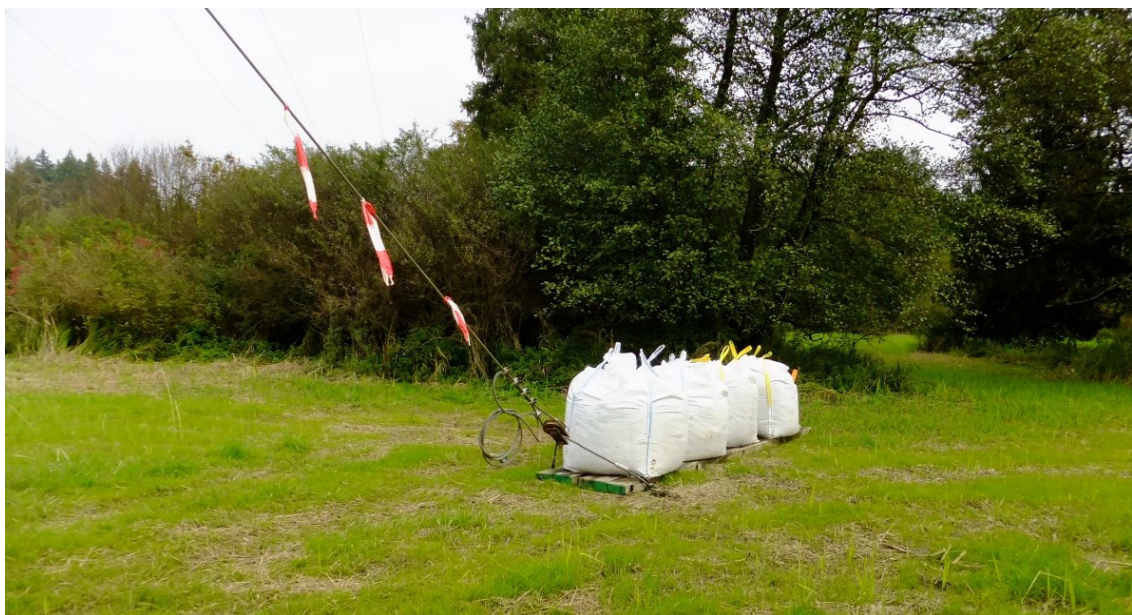
Abbildung 13: Abankerung mittels Ballastschlitten
