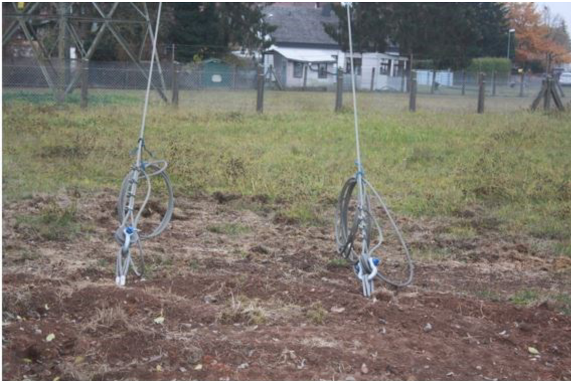
Abbildung 12: Ins Erdreich eingebrachte Anker
