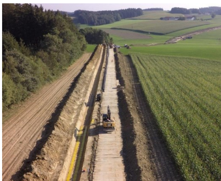
Abbildung 8: Verlegung einer Erdkabelleitung in offener Bauweise
