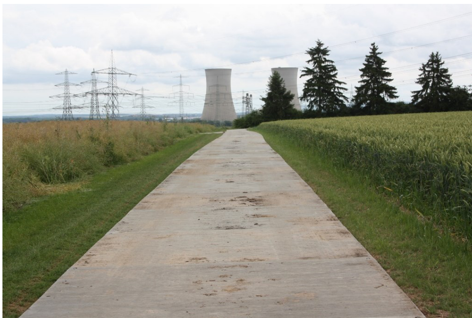
Abbildung 9: Zuwegung über Aluplatten (schwerer Wegebau)
