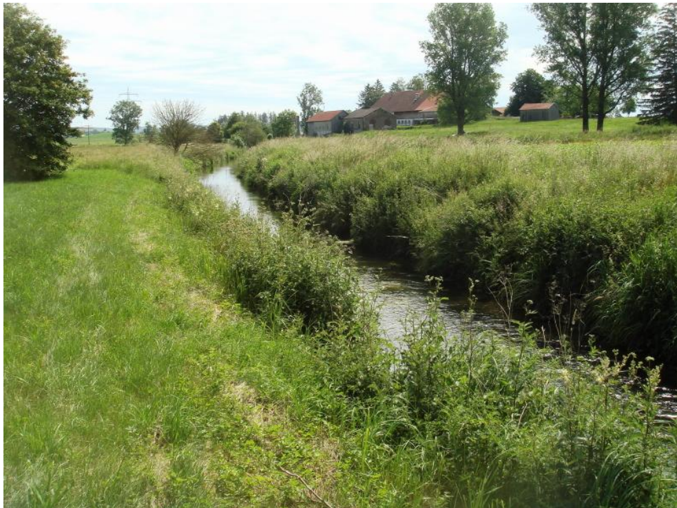
Foto 14 Schönach im Osten von Schwabbruck, Blickrichtung Ost, 25.06.2020 Abschnitt zwischen Kläranlage (links) und Einzelgehöft "Beim Pfannenschmied", im Hintergrund links Maststandort 71
