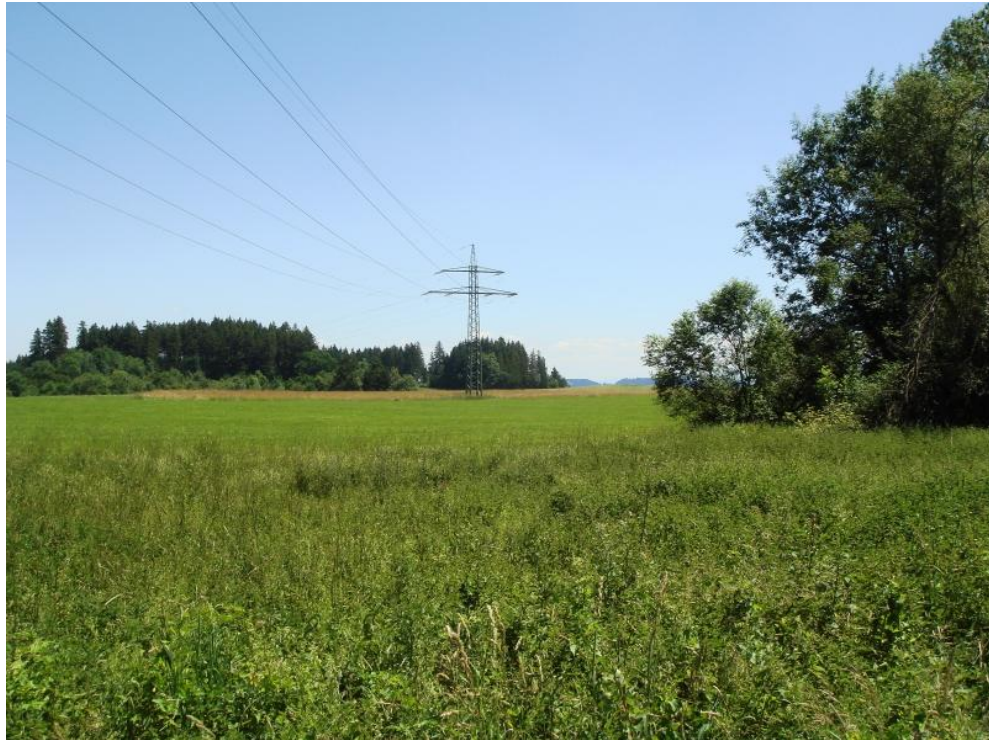
Foto 1 Trassenabschnitt im Westen nordöstlich Mooshof, Blickrichtung Ost, 16.06.2018: Im Vordergrund Brachfläche, dahinter Intensivgrünland, rechts Wäldchen am Mooshof, in der Bildmitte Maststandort 57
