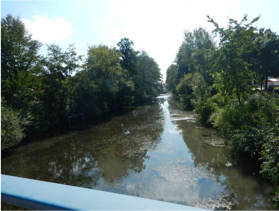
Abb. 2-1 Pfettrach stromabwärts der Brücke Bahnhofstraße Einstaubereich des Schlauchwehrs, Ufer mit gewässerbegleitenden Gehölzen und Hochstaudenfluren
