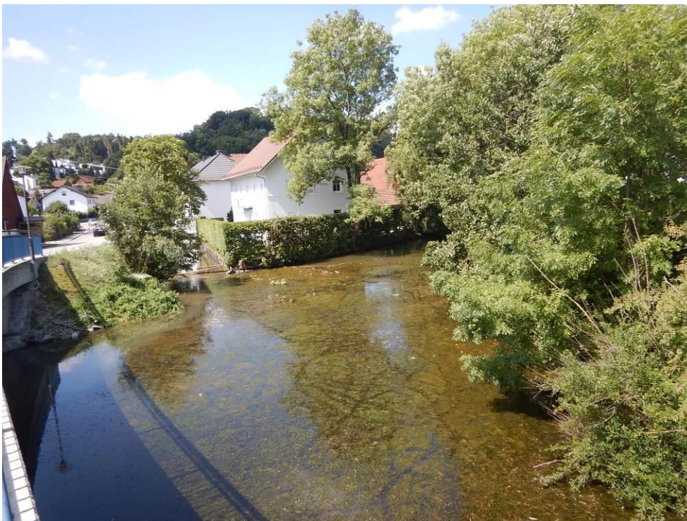
Abb. 2-2 Pfettrach nördlich der Brücke Bahnhofstraße Mündung Mühlbach und direkt angrenzende Wohnbebauung
