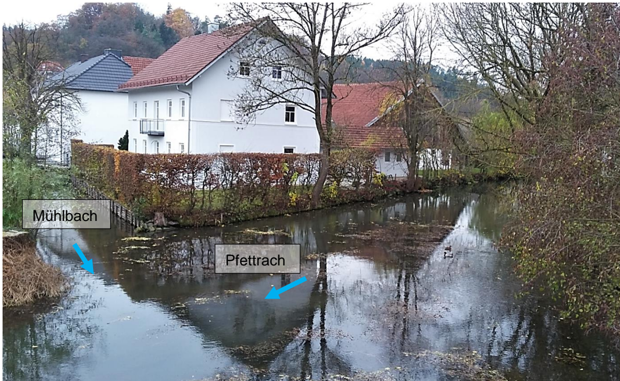
Abbildung 3.3: Mündung des Mühlbachs in die Pfettrach nördlich der Bahnhofstraße
