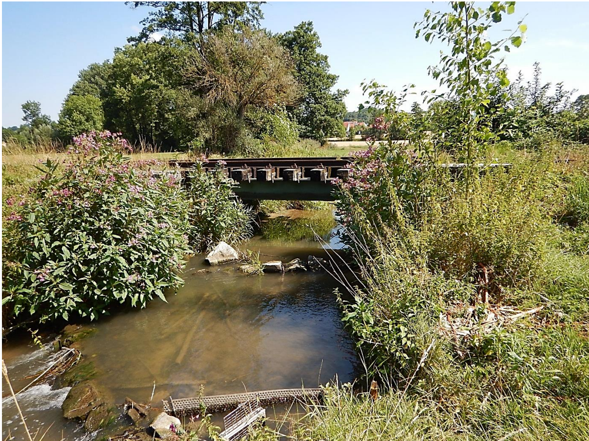
Abbildung 4.12 Blick von Osten auf den Mühlbachdurchlass unter dem Bahndamm
