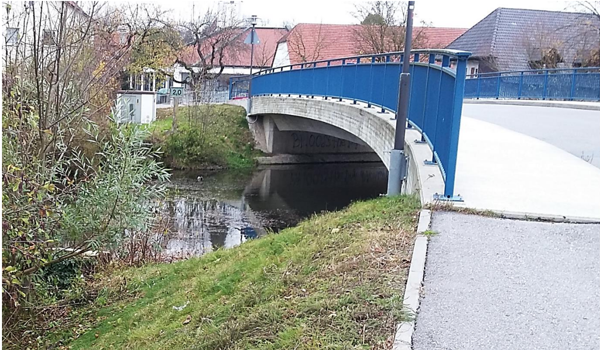
Abbildung 3.4: Abflussquerschnitt unter der Hirschauer Brücke (Blick nach Osten)
