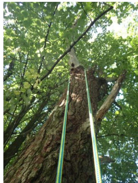
Abb. 2: Fertiger Seileinbau (Baum Nr. 30).
