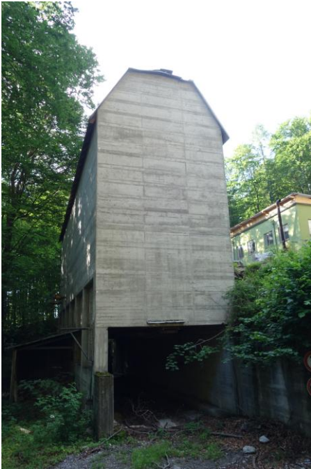
Abbildung 24: Gebäude 1 wird als Quartier vom Großen Mausohr genutzt.
