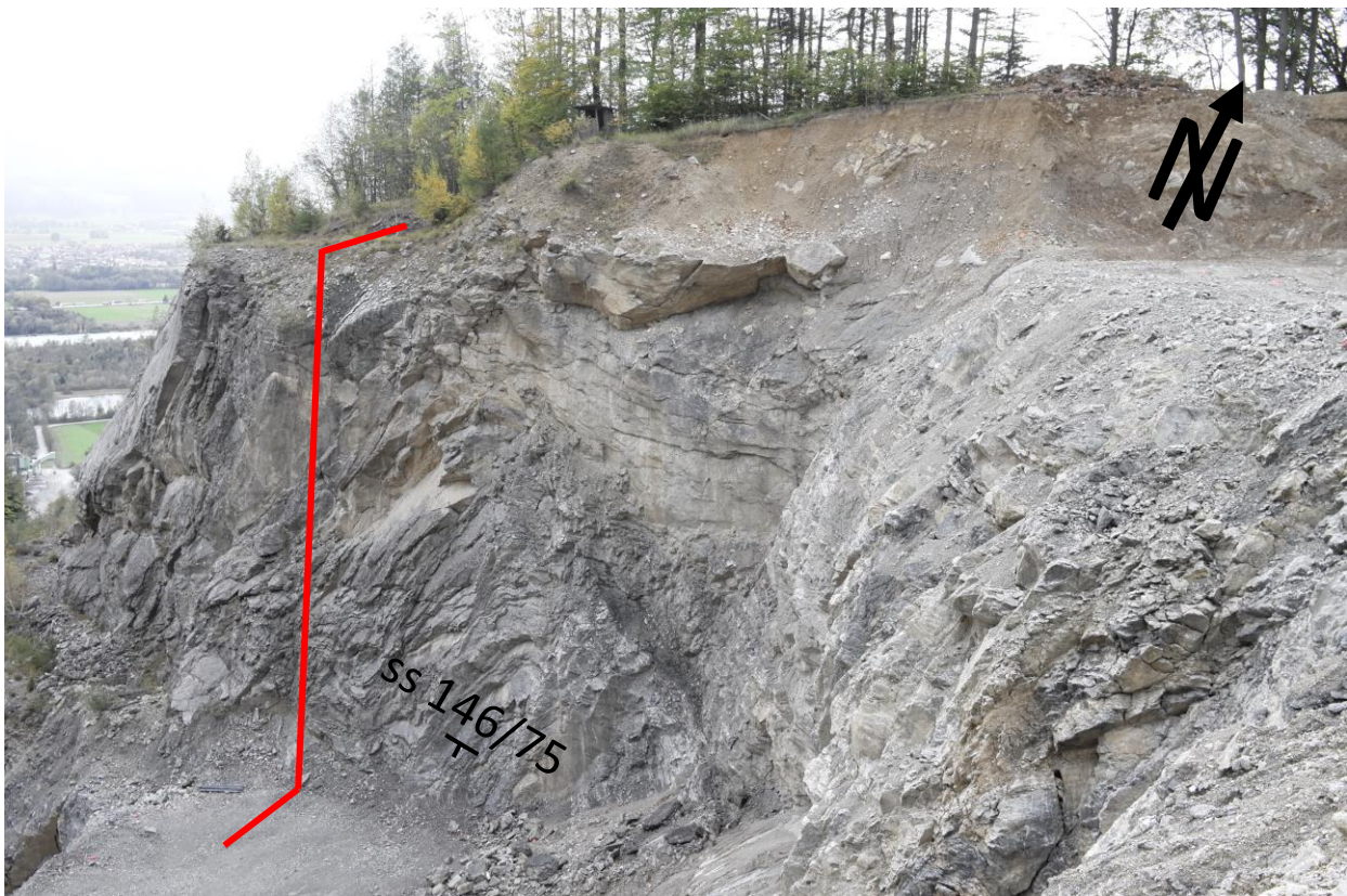
Abb. 2: Bestandsböschung im Steinbruch Überfilzen. In Rot ist der für die Modellierung maßgebende Schnitt eingezeichnet.
