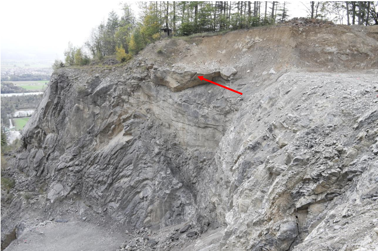
Abb. 31: Potentiell gefährlicher Block an der Sichtschutzwand.
