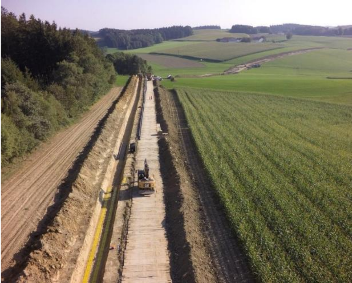
Abbildung 3: Verlegung von zwei 110-kV Kabelsystemen
