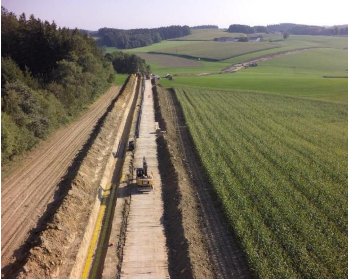
Abbildung 3: Verlegung von zwei 110-kV Kabelsystemen
