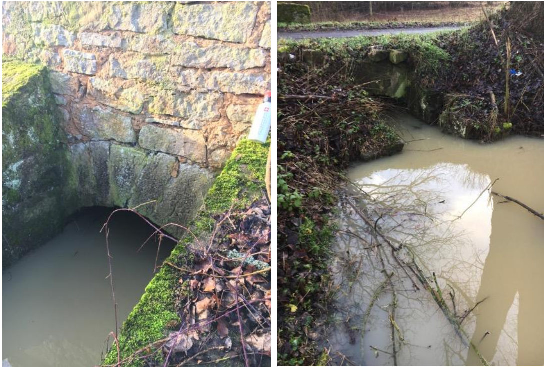
Abb. 42: Durchlass Mühlbach, Ansicht Richtung Süd bzw. Nord
