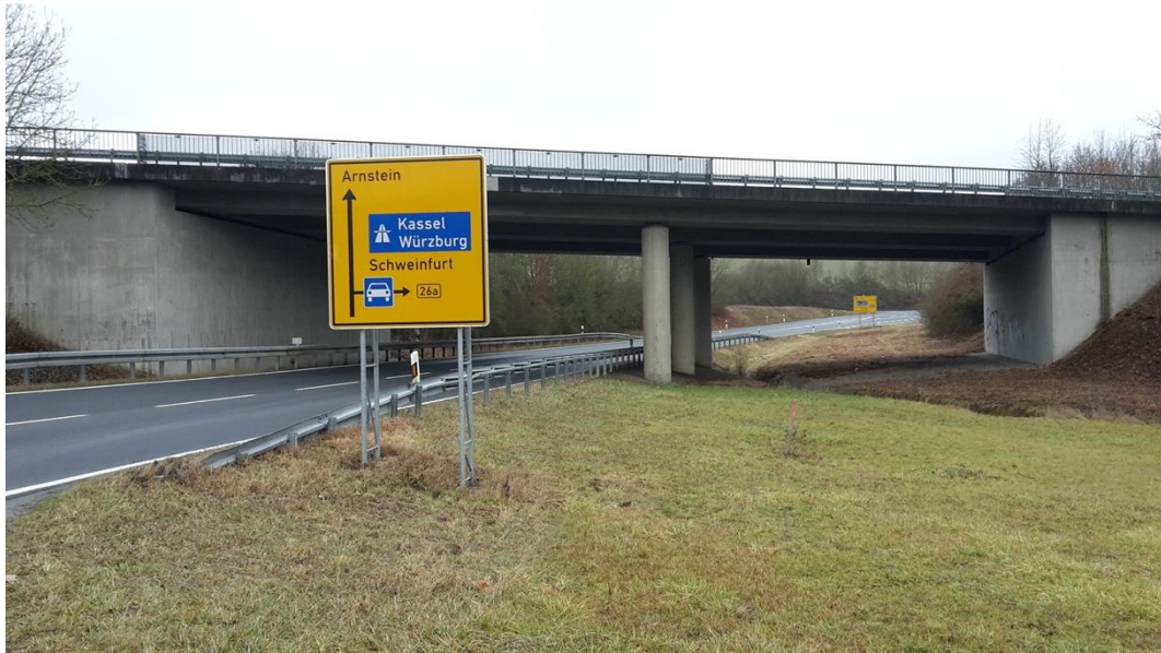
Abb. 13: Bestehendes zweifedriges Brückenbauwerk über die St 2277 von Norden betrachtet.
