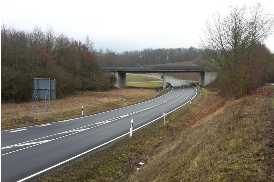
Abb. 14: Brücke über die St 2277 von Süden betrachtet.
