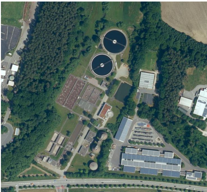
Abbildung 1: Luftbild Klärwerk Schönmühle (Quelle: Umweltatlas, Oktober 2023)
