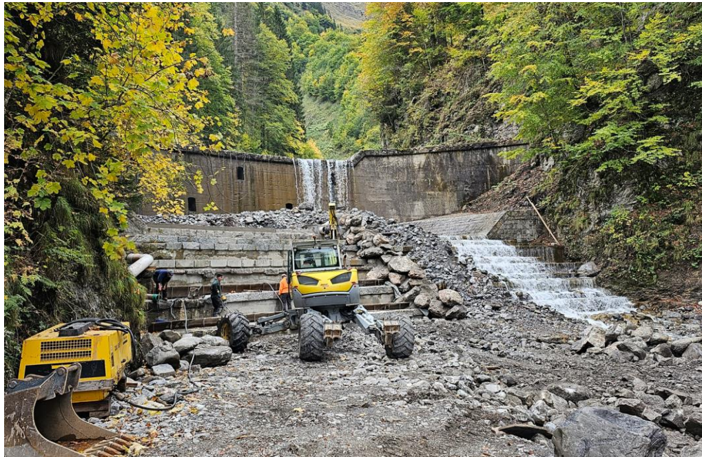
Abb. 57: Wasserhaltung WWA Ke bei der Sanierung der Sperren-Nachbettsicherung 2023
