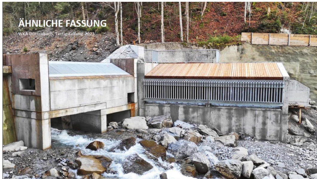
Abb. 31: Foto einer ähnlichen Fassung mit Tiroler Wehr (links) und Conda-Rechen mit davorliegendem Schutzrechen und Holzabdeckung (rechts)
