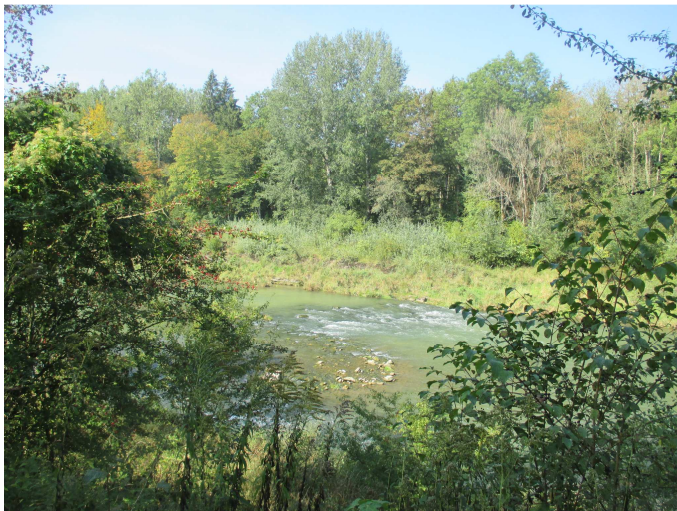
Bild 5: Sohlquerriegel im Unterwasser der Mooshauser Schwelle mit deutlich erkennbarem turbulentem Abfluss
