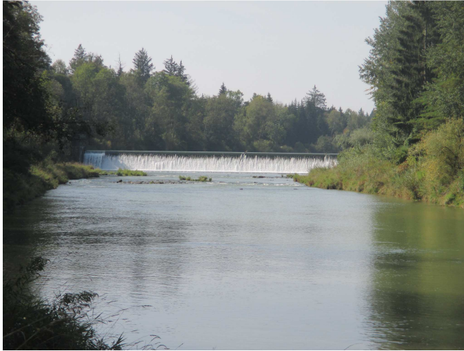
Bild 4: Blick gegen die Fließrichtung, vom Unterwasser aus auf die Mooshauser Schwelle
