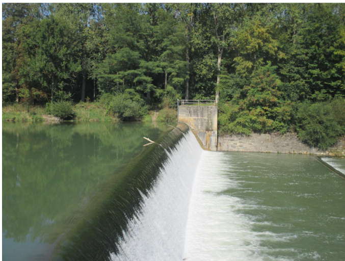
Bild 2: Blick auf das orografisch linke Ufer der Mooshauser schwelle
