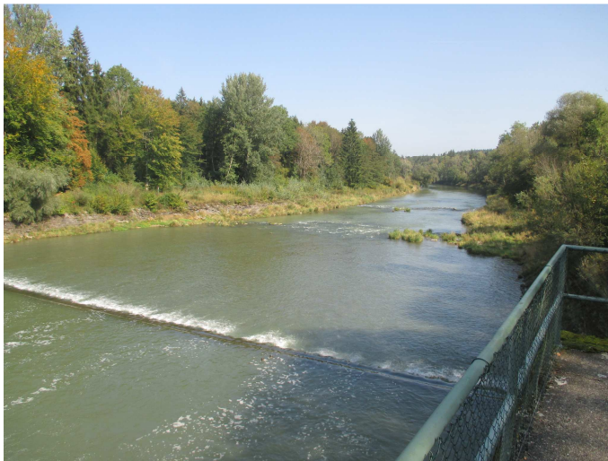
Bild 1: Blick vom orografisch rechten Ufer aus ins Unterwasser der Mooshauser Schwelle, deutlich erkennbar die Spundwand zur Sohlsicherung und zwei weitere Querschwellen mit turbulentem Abfluss
