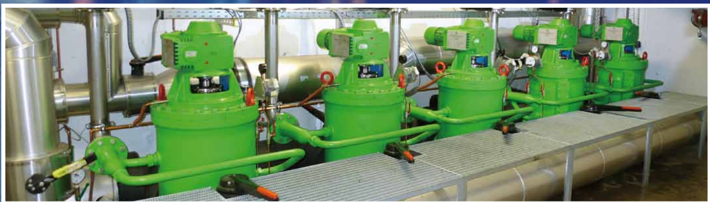
Abb. 18: MUSCHEL STOP-Anlage in der Flussfiltration
